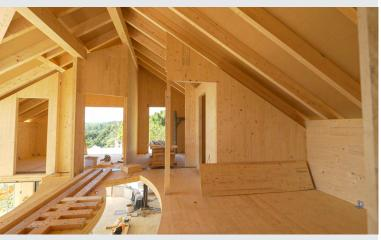
A construção CLT (*Cross Laminated Timber*) é um método inovador que utiliza painéis de madeira estruturalmente reforçados, criando edifícios sustentáveis e modernos.
